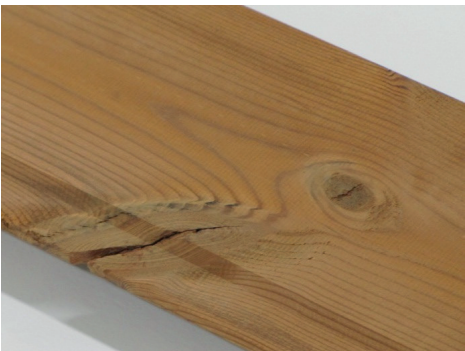
Enkelt revne af en knast er tilladt
