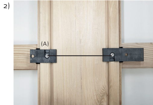
Clipsene monteret overfor hinanden, tilpasset alle strøer
