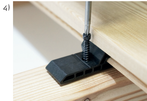
Fastgør ikke-delte clips i strøerne, skruen skal ikke undersænkes
